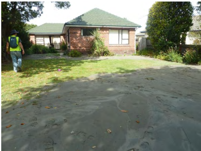
o) Liquefaction ejecta, dwelling tilting
