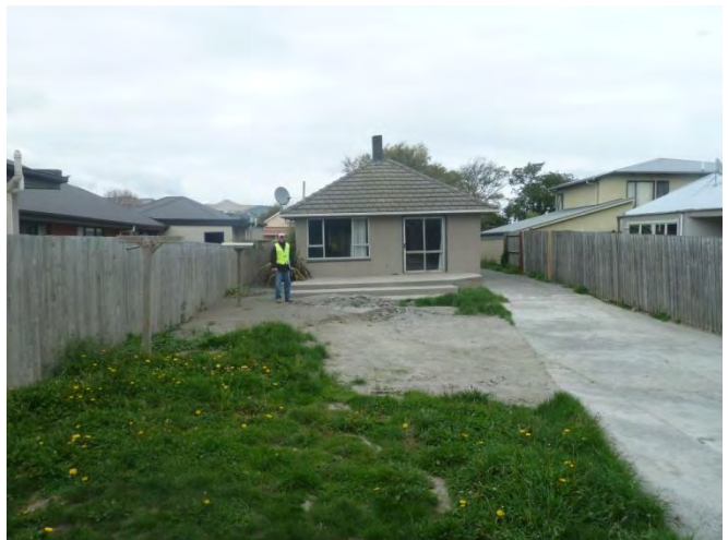
p) Liquefaction ejecta, dwelling tilting
